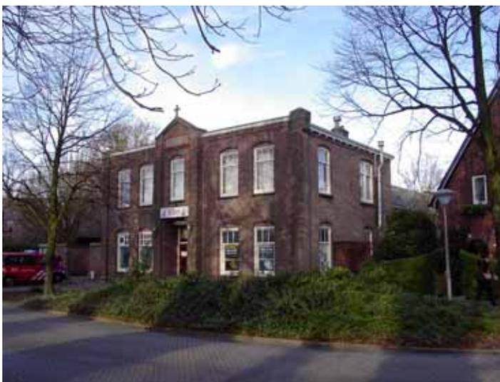
*Bijz. bijgeb./bek* : Tegen de linker zijgevel is een bakstenen muur met ezelsrug aangebouwd. Boven de licht getoogde doorgang - ter hoogte van de zijgevel – bevindt zich een enkelsteens ontlastingsboog. In de dagkanten van de brede toegang zijn hardstenen elementen verwerkt.
