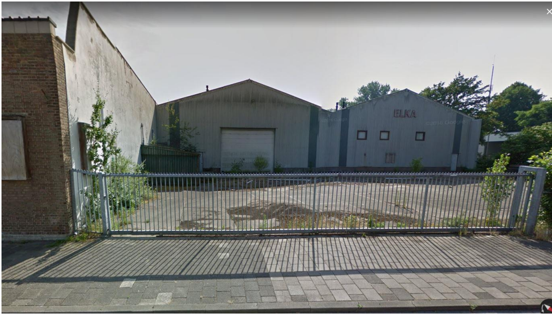
Impressie huidige bebouwing (bron: google maps)
