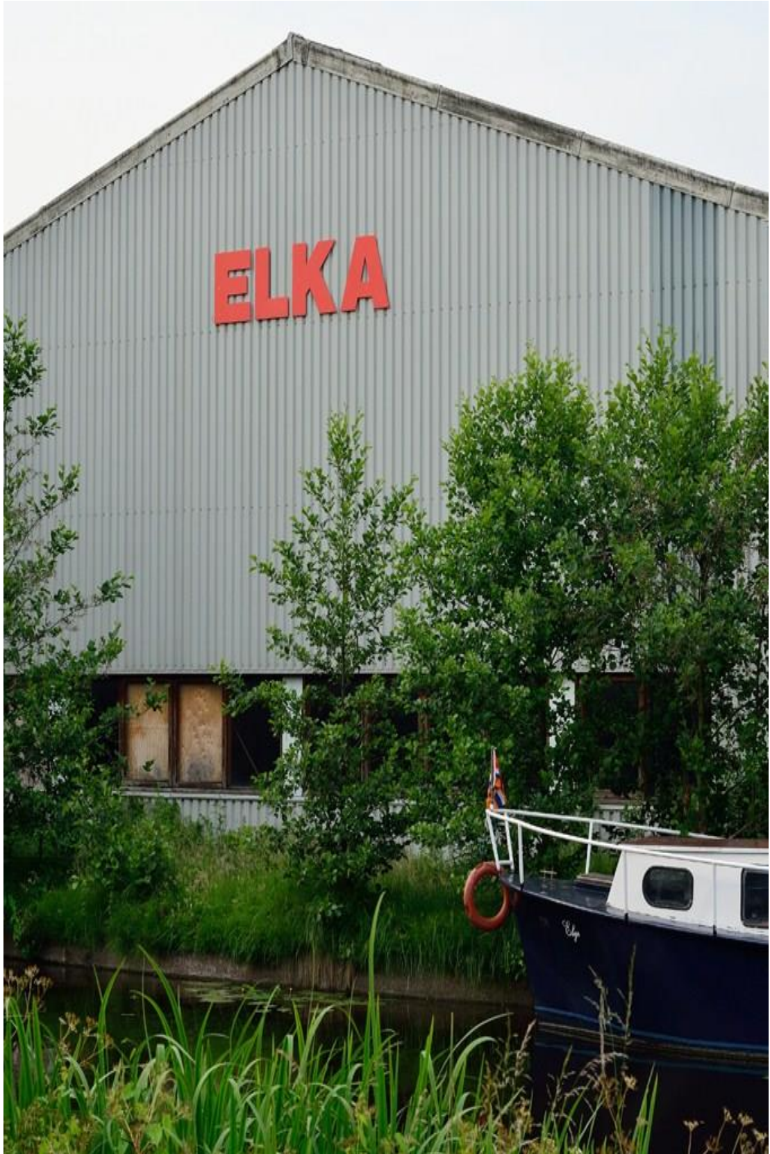
Oude kistenfabriek ELKA gezien vanaf de Ruishornlaan
