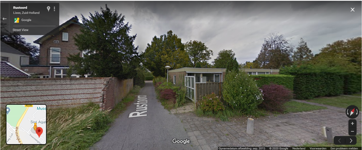
Figuur 6: Het te slopen gebouw voor statushouders is rechts van de villa
